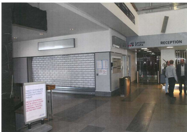
stav před rekonstrukci příletové haly T1
