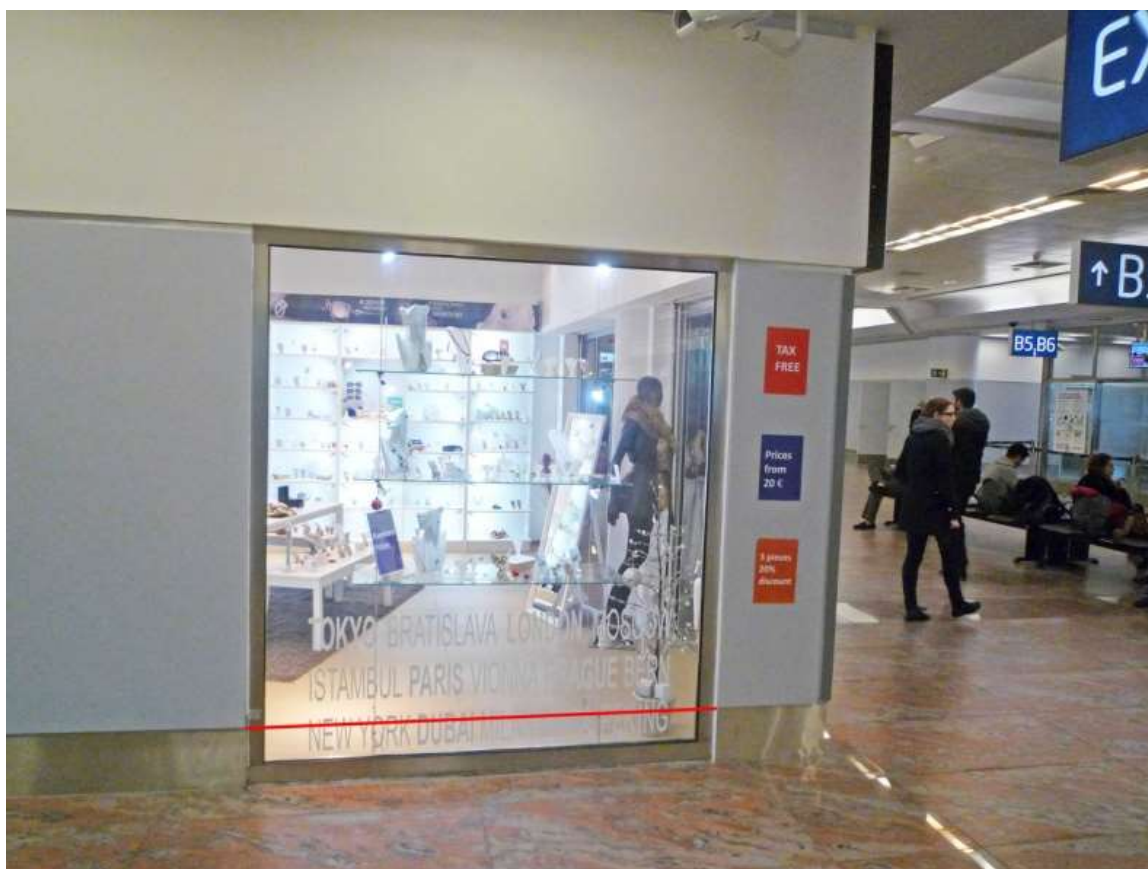
Ukázka nevhodného provedení výlohy (spodní profil je nižší než stávající sokl - správně mají by ve stejné úrovni)
